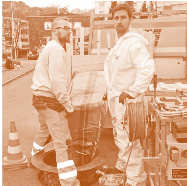
Ein mit Epoxidharz getränkter Kunststoffgewebeschauch wird in den Kanal eingebracht und anschließend mit UV-Licht ausgehärtet.
